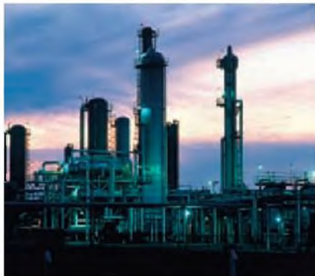
▲ Figura 13.21 Separación de componentes volátiles. En torres de destilación industrial, como las que aparecen en esta fotografía, los componentes de una mezcla orgánica volátil son separados de acuerdo con el intervalo de puntos de ebullición.
